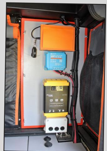
Sur le côté droit du Canopy Camper, vous retrouvez le panneau électrique avec le coupleur/régulateur de charge Energie Mobile gérant le panneau solaire.
